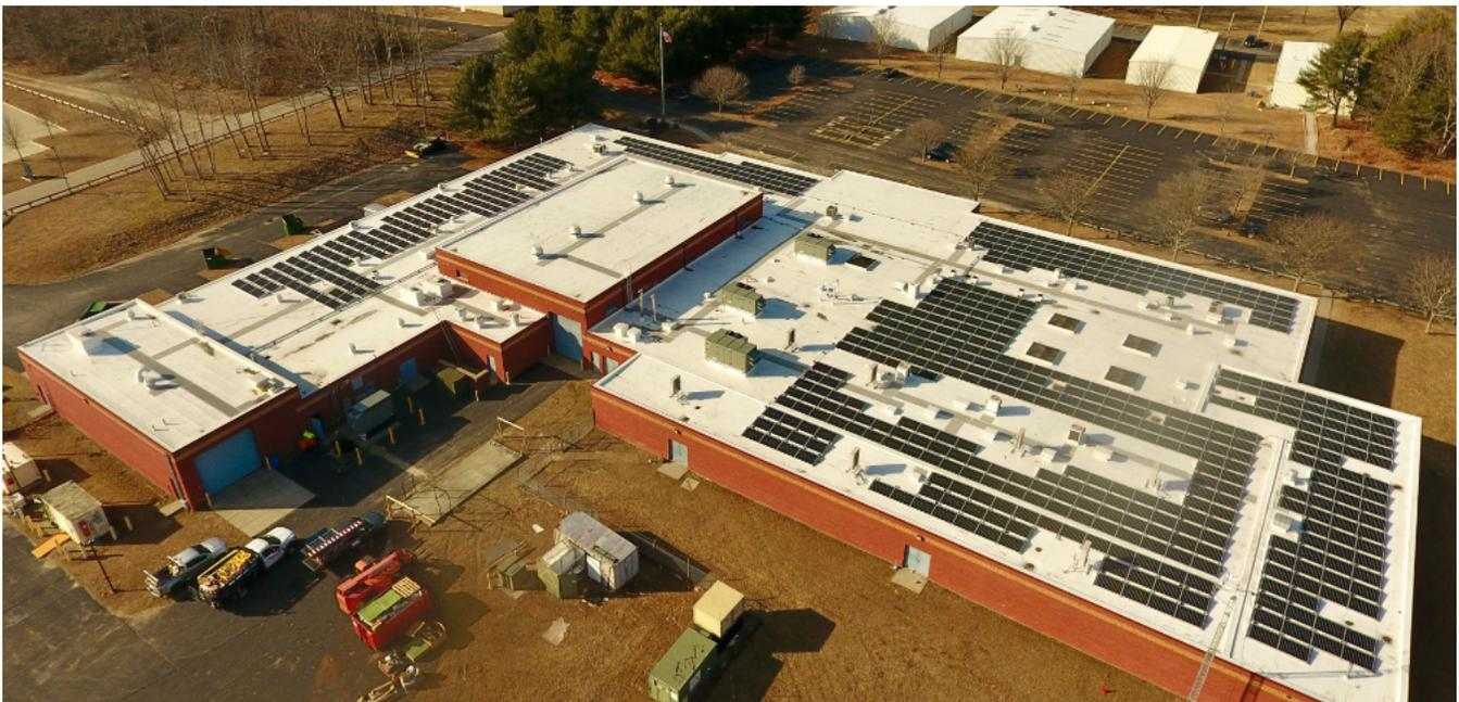
La Guardia Nacional instaló el mayor sistema solar en tejado en instalaciones estatales, con una capacidad de 210 kW en la placa de identificación.
