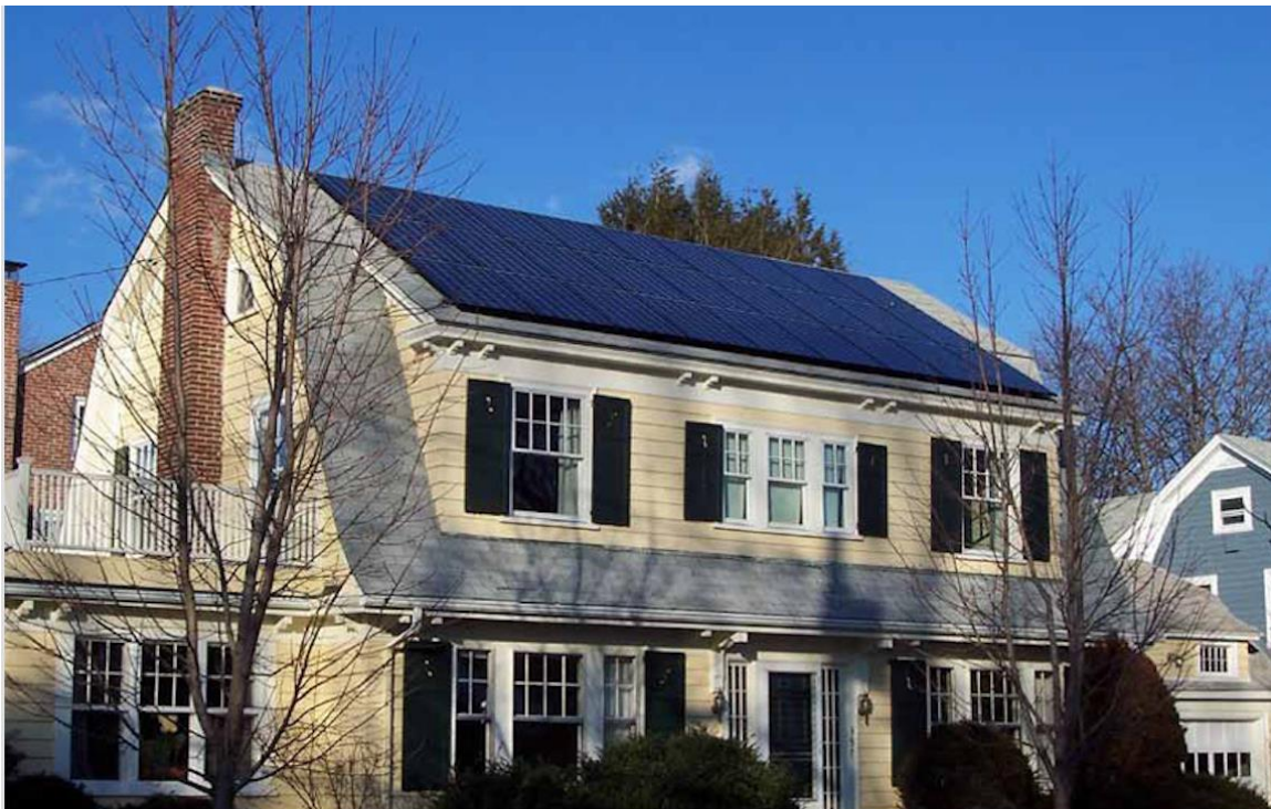
Figura 5: Instalación de RGS Energy Solar
